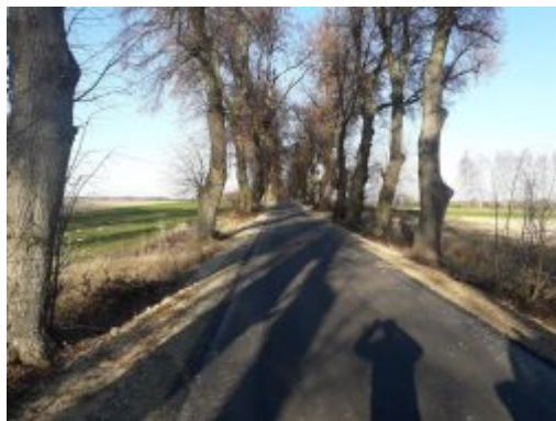
Przebudowana droga gminna w Wygnance
