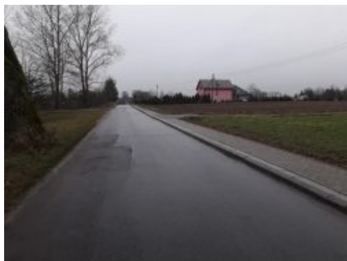
Budowa chodników przy drogach gminnych w Talczyń
