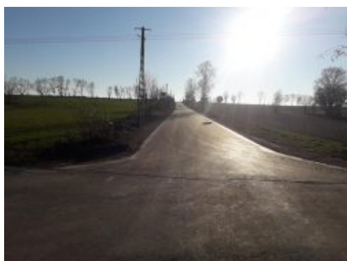
Przebudowana droga gminna w Białobrzegach
