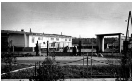
Baza magazynowa GS
