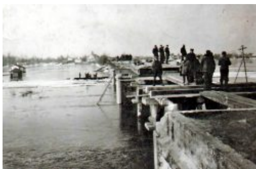
Budowa mostu na Tyśmienicy
