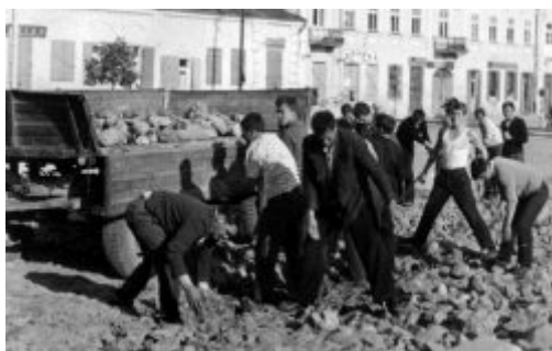
Prace porządkowe na rynku
