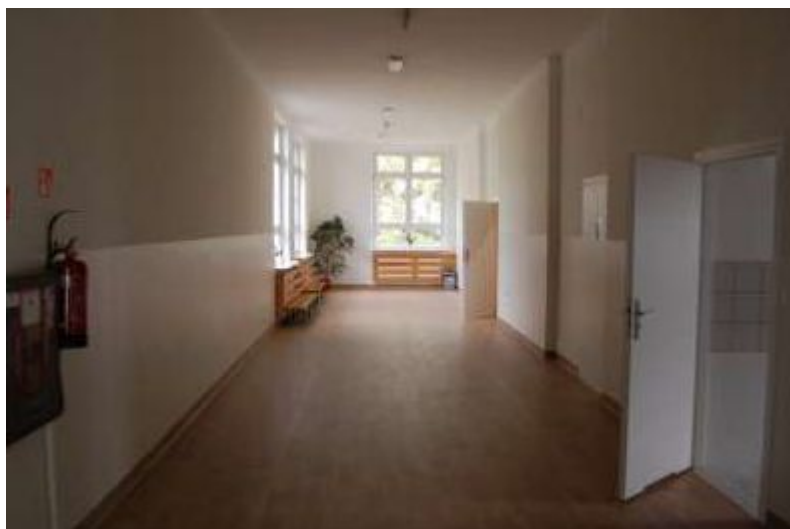
Korytarz zmodernizowanego budynku szkoły w Poizdowie
