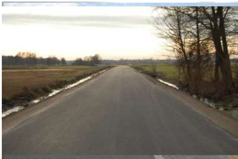
Przebudowana droga gminna w Białobrzegach
